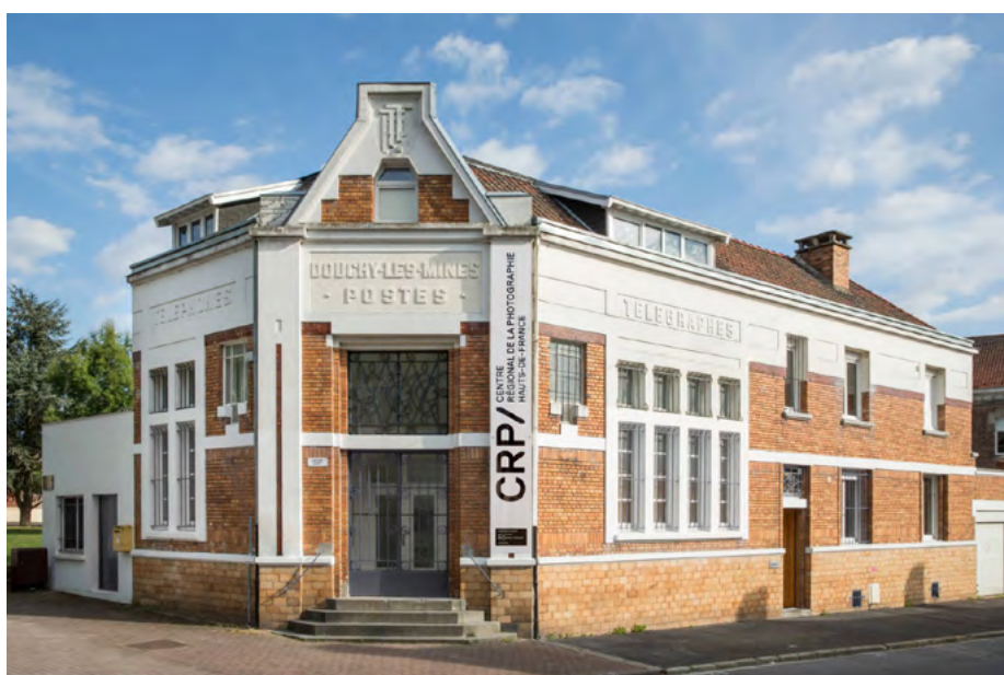
Façade du CRP/ © Vincent Everarts
