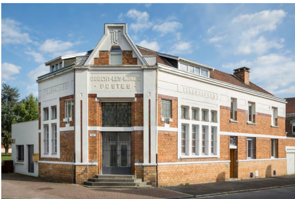
Façade du CRP/ © Vincent Everarts.
