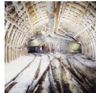
Fosse 6 d'Haillicourt, raccordement de deux bowettes, 1977.
