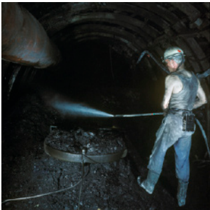
Lutte contre les poussières sur un chantier de creusement.
