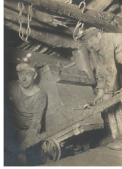
Le rouleur. Une berline lancée dans le plan incliné a déraillé, les rouleurs la remettent sur les rails. Octobre 1902. Ph. M. Corriol (ingénieur)
