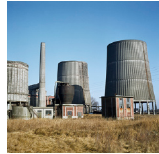
Centrale de Beuvry avant démantèlement. 5 mars 1979. Ph. Claude Druelle.
