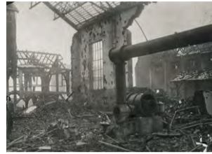
Compagnie des Mines de Courrières. Siège 21/22, usine de récupération, salle des machines.
