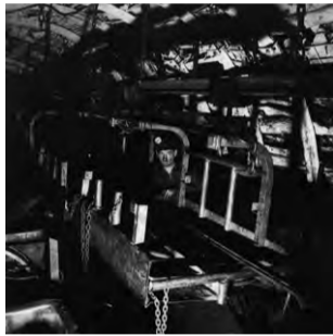
7 de Wingles St Louis, trémie du point de chargement monorail. 1964.
