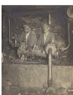
Compagnie des Mines de Carvin. La pompe. Dans différents points de la mine, de petites pompes à air comprimé prennent les eaux pour les refouler dans un réservoir commun où une forte pompe les remonte au jour. Octobre 1902. Ph. M. Corriol (ingénieur). Reproduction 42 x 32,9 cm, d'après un album de 33 photographies. 8,7 x 11 cm.
