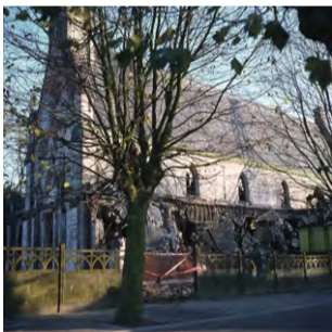
Démolition de l'église d'Avion. 24 novembre 1978.
