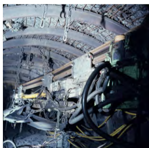
9 d'Oignies, démantèlement de la taille Henriette 753, tirant hydraulique. 15 mars 1982. Ph. Claude Druelle. Reproduction 39 x 39 cm, d'après Ektachrome.
