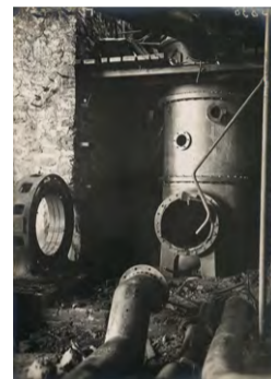
Compagnie des Mines de Courrières. Siège 3/15. Condensateur du turbo-alternateur.
