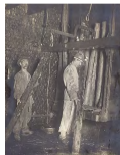
Compagnie des Mines de Carvin. La descente des bois. La cage étant au fond du puits, on en retire les bois de mine afin de les conduire aux chantiers. Octobre 1902. Ph. M. Corriol (ingénieur). Reproduction 42 x 32,9 cm, d'après un album de 33 photographies. 8,8 x 11 cm.
