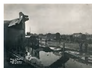
Compagnie des Mines de Nœux-les-Mines. Bache à Goudron. 14 août 1918.
