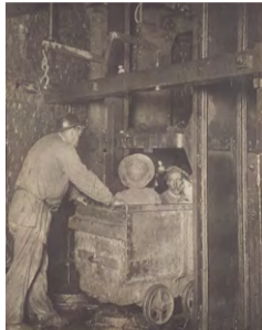
Compagnie des Mines de Carvin. La remonte des ouvriers. Les ouvriers se placent dans une berline qu'on roule dans la cage reposant sur les taquets. Au-dessus de l'emballeur se trouve le levier de la sonnette qui sert à donner au mécanicien du jour, le signal de la remonte. Octobre 1902. Ph. M. Corriol (ingénieur). Reproduction 42 x 32,9 cm, d'après un album de 33 photographies. 8,5 x 11,1 cm.
