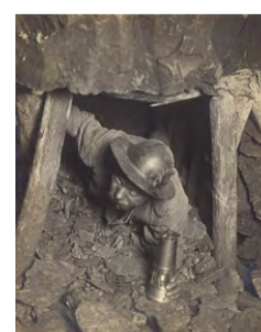
Compagnie des Mines de Carvin. Visite des travaux. Le chef porion descend par une cheminée, il est au-dessous d'un caillou qui a cassé le bois le soutenant, une cassure s'est formée à droite dans le terrain, l'endroit est donc dangereux. Octobre 1902. Ph. M. Corriol (ingénieur). Reproduction 42 x 32,9 cm, d'après un album de 33 photographies. 8,7 x 11,1 cm.
