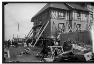
Consolidation d'une maison par de nombreux hommes.
