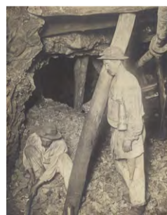
Compagnie des Mines de Carvin. Le boisage. Avant de placer le bois, on prépare un trou ou potia pour loger son extrémité. Octobre 1902. Ph. M. Corriol (ingénieur). Reproduction 42 x 32,9 cm, d'après un album de 33 photographies. 8,6 x 11 cm.
