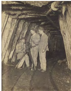
Compagnie des Mines de Carvin. Levée de plan. Les géomètres relèvent une voie à l'aide du théodolite. Octobre 1902. Ph. M. Corriol (ingénieur). Reproduction 42 x 32,9 cm, d'après un album de 33 photographies. 8,7 x 11,1 cm.
