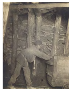
Compagnie des Mines de Carvin. Le rouleur. Les berlines viennent former les trains dans les voies principales, conduites une à une par le rouleur, jeune garçon de 16 à 18 ans. Octobre 1902. Ph. M. Corriol (ingénieur). Reproduction 42 x 32,9 cm, d'après un album de 33 photographies. 8,8 x 11,1 cm.
