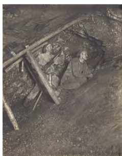
Compagnie des Mines de Carvin. Le lavage. Muni d'une riveline, outil à lame plate, un ouvrier coupe la base de la veine pour faciliter la chute du charbon. Le second ouvrier place sa perforatrice pour forer un trou de mine dans le charbon. Octobre 1902. Ph. M. Corriol (ingénieur). Reproduction 42 x 32,9 cm, d'après un album de 33 photographies. 8,5 x 11 cm.
