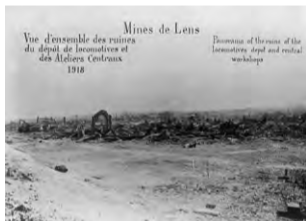
Compagnie des Mines de Lens. Vue d'ensemble des ruines du dépôt de locomotives et des ateliers centraux. 1918.
