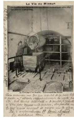
Fonçage d'une beurtia, enlèvement des terres. Les beurtias sont des puits intérieurs faisant communiquer entre elles des galeries superposées. Série « La Vie du mineur » n° 19. s.d. Ph. Joseph Quentin, Arras. Reproduction 42 x 27,2 cm, d'après une carte postale.
