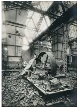
Compagnie des Mines de Courrières. Siège 3/15. Destruction systématique du ventilateur à vapeur. s.d. Ph. non indiqué. Reproduction 17,6 x 24,6 cm, d'après une photographie d'époque 16,8 x 11,9 cm.
