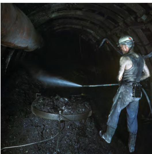
Lutte contre les poussières sur un chantier de creusement. s. d. Ph. non indiqué. Reproduction 36 x 36 cm, d'après Ektachrome.
