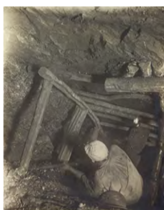
Compagnie des Mines de Carvin. Le lavage. Un ouvrier frappe dans le charbon, sa lampe est piquée à un bois au-dessus de lui: il est en faute avec le règlement car il n'a pas sa barrette (chapeau de cuir) sur la tête. Octobre 1902. Ph. M. Corriol (ingénieur). Reproduction 42 x 32,9 cm, d'après un album de 33 photographies. 8,8 x 11 cm.
