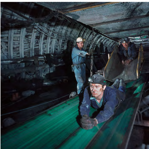
Transport du personnel par bande transporteuse. 1976 Ph. non indiqué. Reproduction 36 x 36 cm, d'après Ektachrome.
