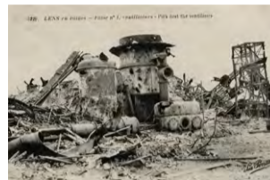
Ruines de la Grande Guerre 1914-1918. Fosse n° 6, structures des bâtiments de triage et du puits, Dourges.
