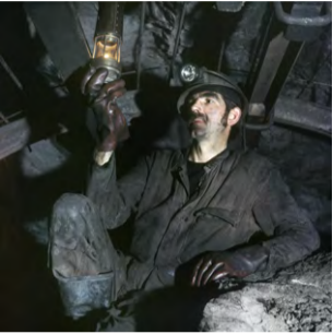
Fosse 9 de l'Escarpelle, mesure du grisou à l'accrochage. 30 août 1977. Ph. Claude Druelle. Reproduction 36 x 36 cm, d'après Ektachrome.
