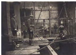
Dénoyage du puits.
