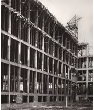
Compagnie des Mines de Lens. Constructions des grands bureaux, fondations du corps central. 20 août 1928. Ph. non indiqué. Reproduction 28,4 x 28,4 cm, d'après un tirage d'époque.
