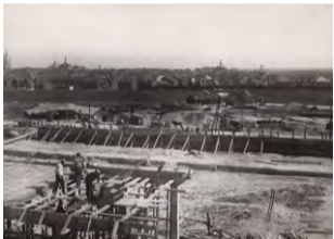
Compagnie des Mines de Lens. Constructions des grands bureaux, cour intérieure, partie arrière des bureaux. 1 er octobre 1928. Ph. non indiqué. Reproduction 28,4 cm x 47,3, d'après un tirage d'époque.
