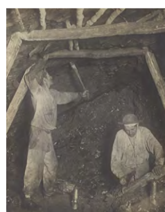
Compagnie des Mines de Carvin. Voie de fond. L'ouvrier cherche à provoquer la chute d'une pierre en faisant levier avec son pic, son compagnon prépare le boisage qui sera placé lorsque la pierre sera tombée. Octobre 1902. Ph. M. Corriol (ingénieur). Reproduction 42 x 32,9 cm, d'après un album de 33 photographies. 8,6 x 11 cm.
