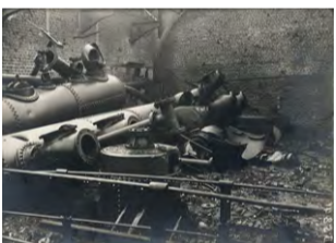
Compagnie des Mines de Courrières. Siège 3/15, dite fosse Charles Boca ou encore Lavaleresse, à Héricourt. Machine alimentaire des générateurs, destruction systématique. s.d. Ph. non indiqué. Reproduction 17,6 x 24,6 cm, d'après une photographie d'époque 16,8 x 11,9 cm.
