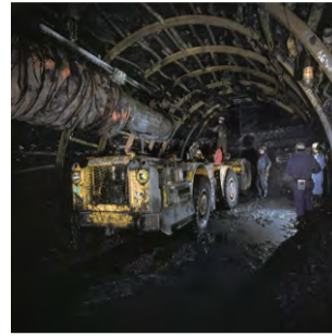
Siège 3/15 de Méricourt, utilisation d'un pantofore au fond. 1973. Ph. Claude Druelle. Reproduction 36 x 36 cm, d'après Ektachrome.
