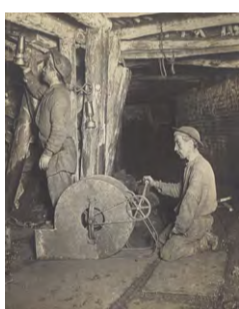
Compagnie des Mines de Carvin. Grisou. La lampe spéciale ayant indiqué la présence du grisou, on fait tourner un petit ventilateur pour le chasser. Octobre 1902. Ph. M. Corriol (ingénieur). Reproduction 42 x 32,9 cm, d'après un album de 33 photographies. 8,7 x 10,9 cm.
